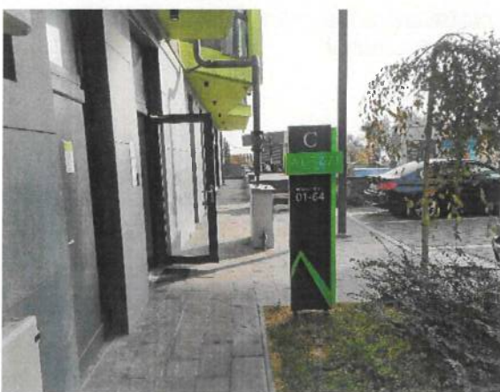
Vedere acces bloc
